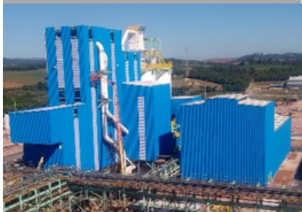
Químico e Petroquímico
